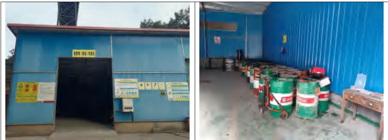
图 3-3 危险废物暂存间
