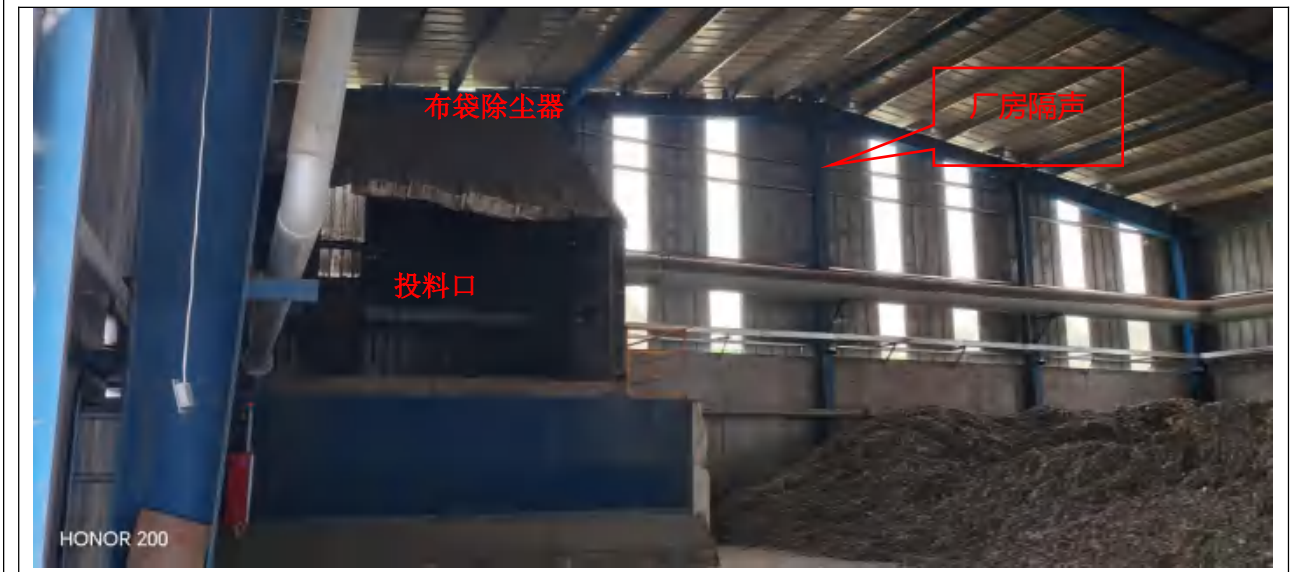
图 3-2 替代燃料暂存间厂房隔声措施
