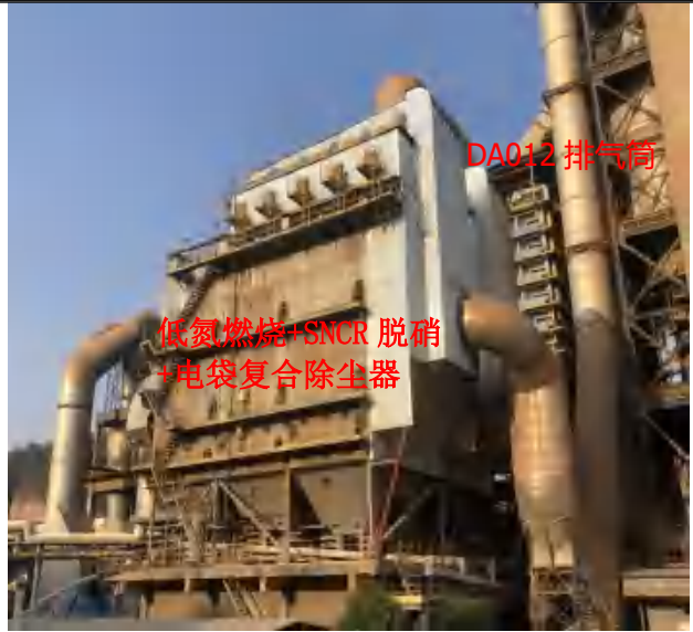
窑尾废气治理设施及排气筒
